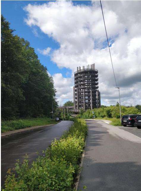
Figuur 24 houten uitkijktoren gemaakt met gelamineerde kolommen
