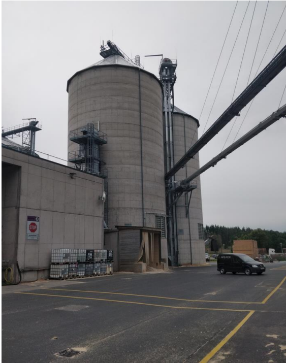
Figuur 18 silo's om het zaagsel op te slaan en te drogen
