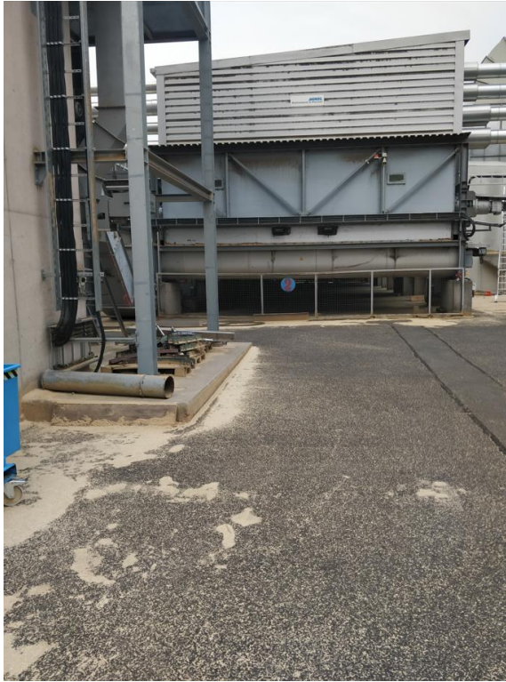
Figuur 19 opslag hout voor dat het getransporteerd wordt
